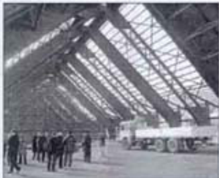
Il capannone in via di ristrutturazione
